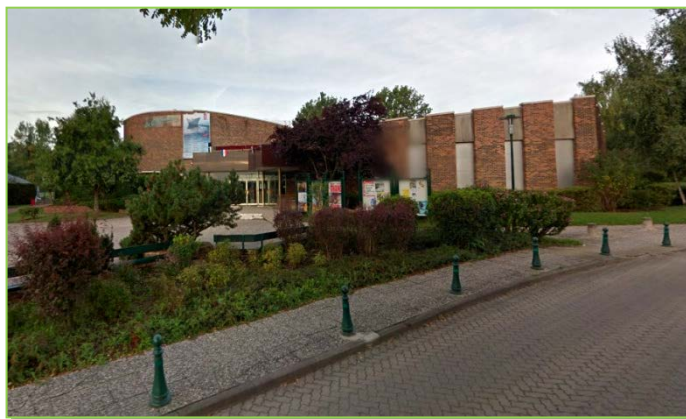
Rénovation / réhabilitation du Colombier
