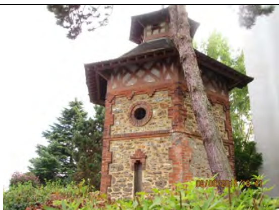
Voie de l'Aulne Colombier
