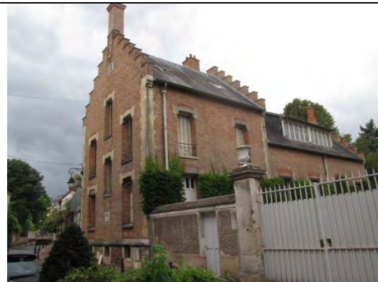
2 bis, rue d'Estienne d'Orves Ancien laboratoire de recherches du Château Vilmorin datant de 1890
