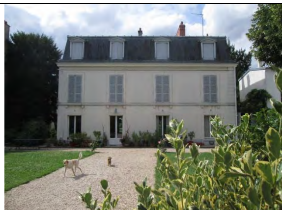
6, place du Poulinat Maison de maître, dit "Le Clair Logis"
