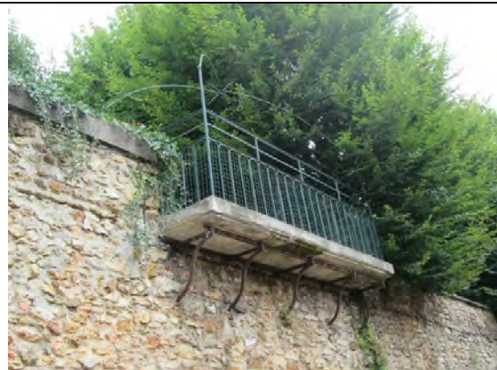
Rue de Migneaux Balcon en fer forgé fixé au mur en meulière de la Maison Vaillant
