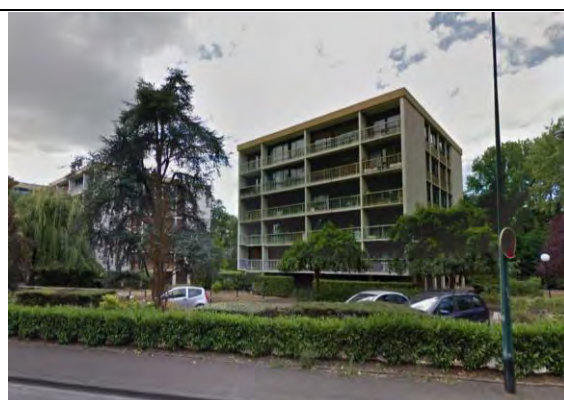
Immeuble collectif Rue Henri Bourrelief
