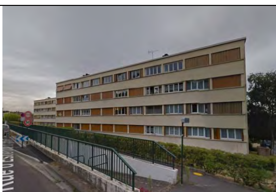
Immeuble collectif Rue Estienne d'Orves
